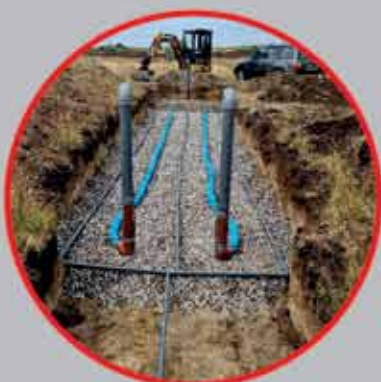
Nedsivningsanlæg m/trixtank
