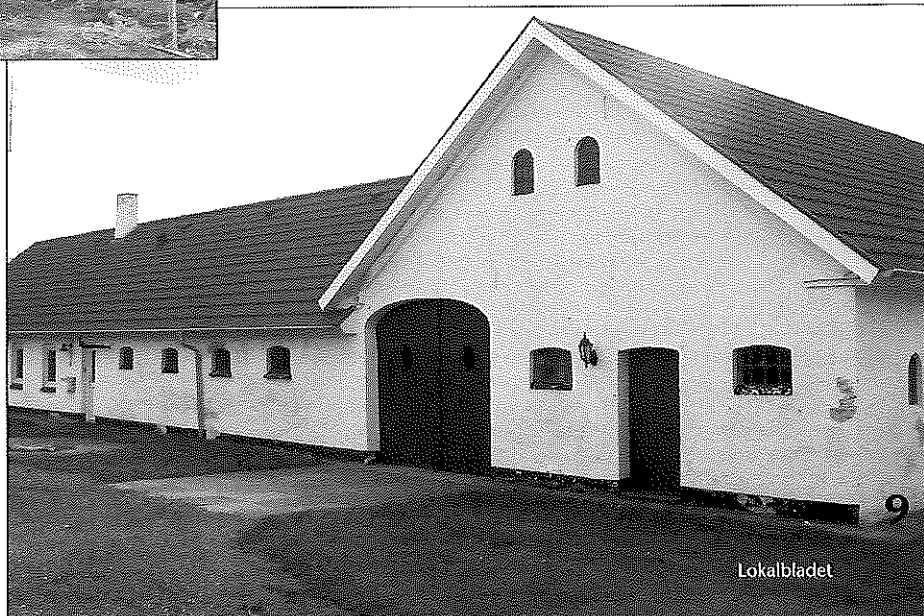
Hallundvej 384 Karl Peter har lagt nyt tag på stuehus og tilbygning.
