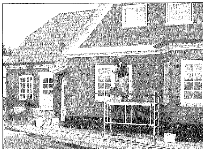
Sølvgade 71 Lis og Eddy fået nye fuger og malet gesimser
