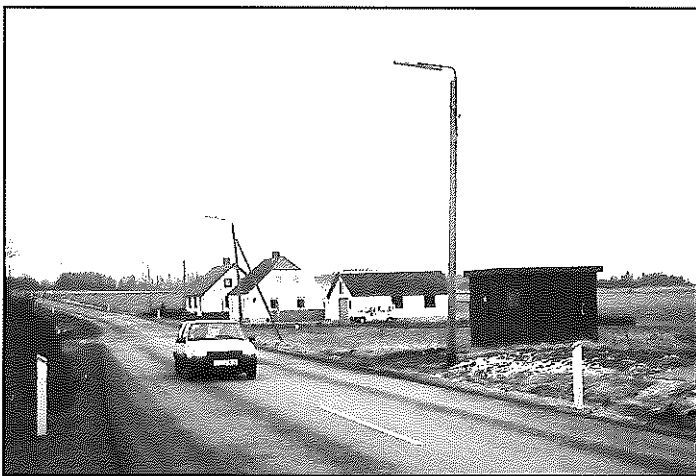
Øster Linderup Frysehus lå ud mod Hallundvej, og på billedet ses stedet, hvor der i dag står en transformator (yderst t.h.).
