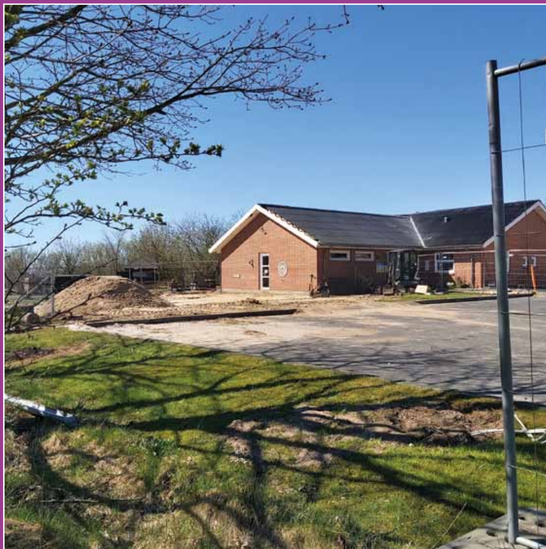
Der er gang i byggearbejdet ved Børnehaven Troldehøj.
